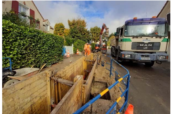
La Celle-Saint-Cloud : Réhabilitation des réseaux EU et EP de l'avenue de Louveciennes et du réseau EP de la place du Maréchal Leclerc sur 430 ml
