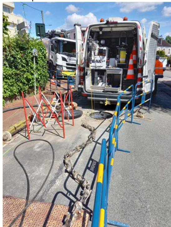
La Celle-Saint-Cloud : Réhabilitation des réseaux EU et EP de l'avenue de Louveciennes et du réseau EP de la place du Maréchal Leclerc sur 430 ml
