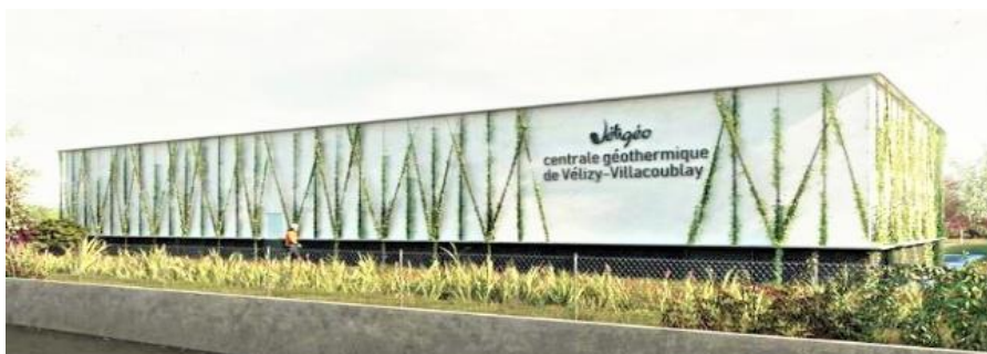
Figure 23 : Usine de géothermie de Vélizy-Villacoublay
