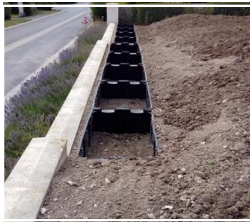
Echelle d'eau en cours de construction
