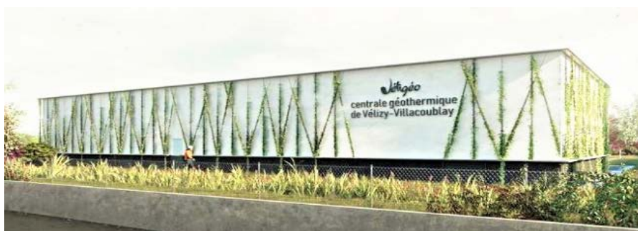
Figure 23 : Usine de géothermie de Vélizy-Villacoublay
