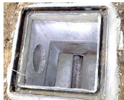
**La présence de la cunette en fond de boîte est obligatoire.** Si la cunette n'est pas préfabriquée, elle peut être créée avec du béton coulé autour d'un demi tuyau en pvc.
