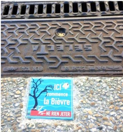
Les grilles des caniveaux sont des ouvertures sur les réseaux des eaux pluviales. En cas de réseau séparatif, ce réseau est directement connecté au milieu naturel : dans nos régions les rivières (Seine, Bièvre, Mauldre), et dans d'autres régions la mer.
