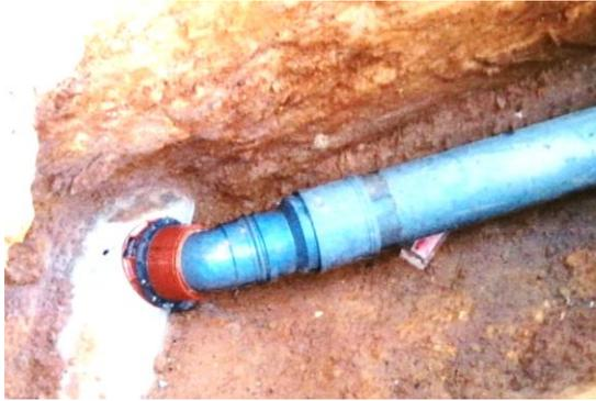
Figure 49: raccord type Fabekun dans tranchée, Versailles
