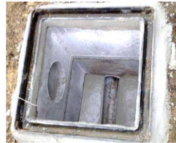
La présence de la cunette en fond de boîte est obligatoire. Si la cunette n'est pas préfabriquée, elle peut être créée avec du béton coulé autour d'un demi tuyau en pvc. Les dimensions minima requises sont de 50 cm x 50 cm.
