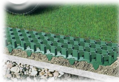
Figure 14: Parking permettant l'infiltration : dalles alvéolées engazonnées
