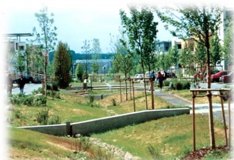
Figure 9: Noues paysagères (fossés à faible pente pouvant stocker la pluie pendant l'infiltration)
