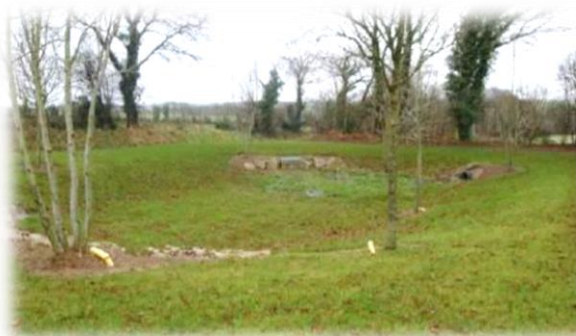
Figure 10: Bassins d'infiltrations à ciel ouvert
