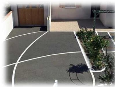
Figure 12: Allée de garage en béton drainant
