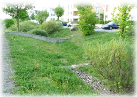
Figure 9: Noues paysagères (fossés à faible pente pouvant stocker la pluie pendant l'infiltration)
