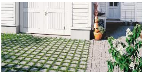
Figure 26: Pavés non jointifs engazonnés
