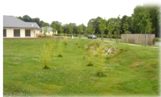
Figure 10: Bassins d'infiltrations à ciel ouvert
