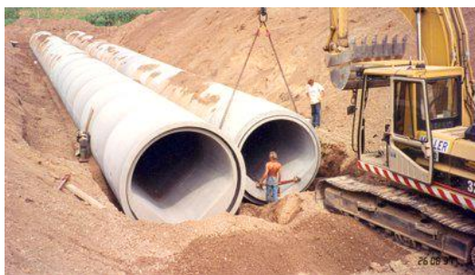
Figure 4: Canalisation d'eaux pluviales en béton
