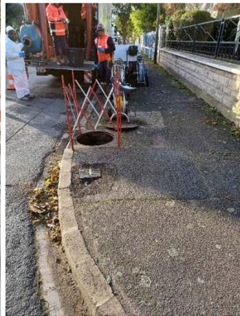
Création d'une boîte de branchement dans l'encombrement des réseaux Travaux en sécurité
