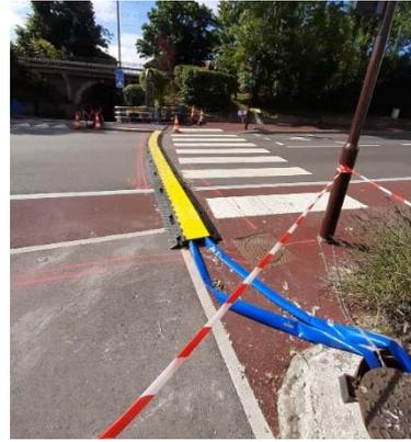
Mise en place d'un système de pompage pour dérivation des effluents
