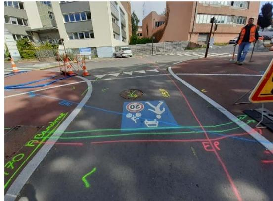
Inspection télévisée du collecteur obturé par le coulis de béton – Marquage des réseaux avant travaux
