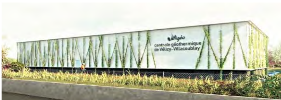
Figure 23 : Usine de géothermie de Vélizy-Villacoublay
