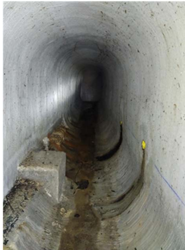
Viroflay, avenue Marguerite rénovation de la canalisation DN200 et reprise des branchements
