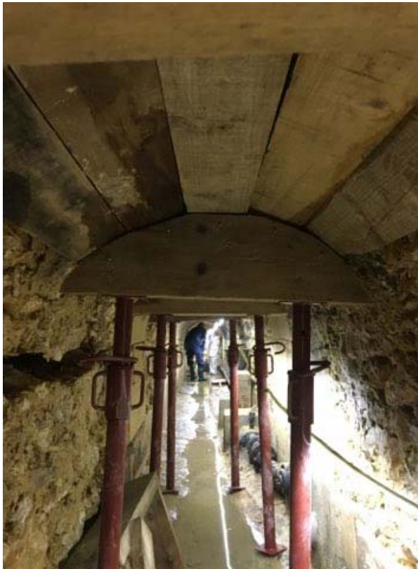
Viroflay, avenue Marguerite rénovation de la canalisation DN200 et reprise des branchements
