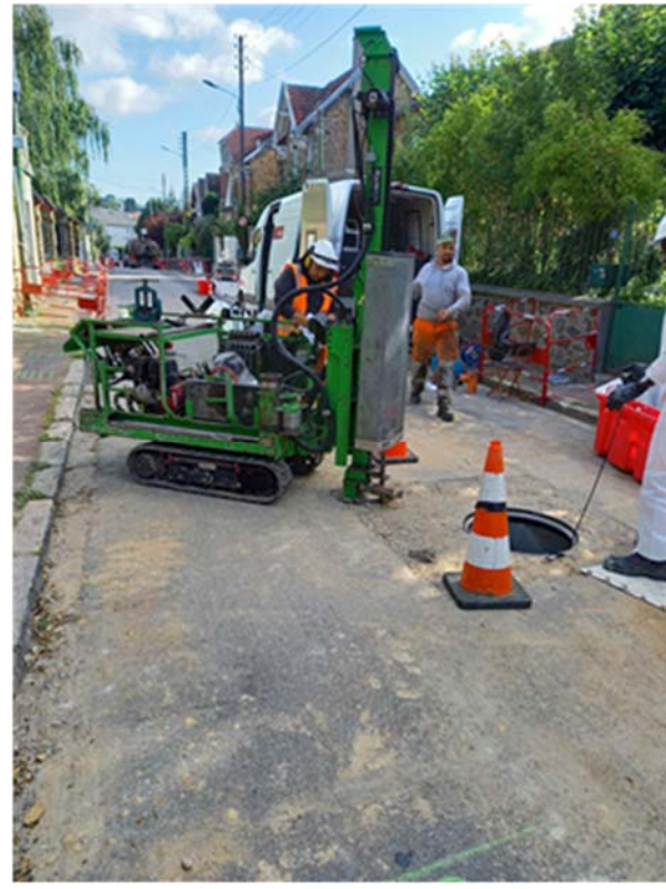
Viroflay, avenue Marguerite rénovation de la canalisation DN200 et reprise des branchements
